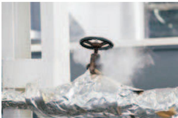
Não se esqueça de que o isolamento térmico de suas instalações também tem uma vida útil, devendo ser mantido dentro dos padrões aceitáveis através de inspeções freqüente.
